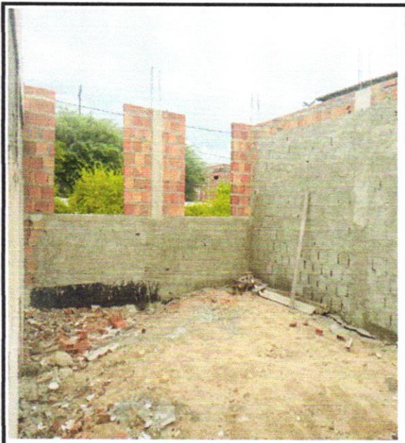
FOTO - 23 CHAPISCO APLICADO EM ALVENARIAS E ESTRUTURAS DE CONCRETO INTERNAS, COM COLHER DE PEDREIRO
