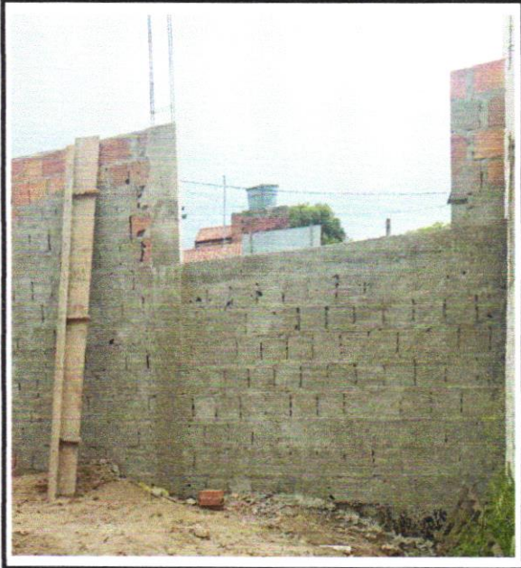
FOTO - 23 CHAPISCO APLICADO EM ALVENARIAS E ESTRUTURAS DE CONCRETO INTERNAS, COM COLHER DE PEDREIRO
