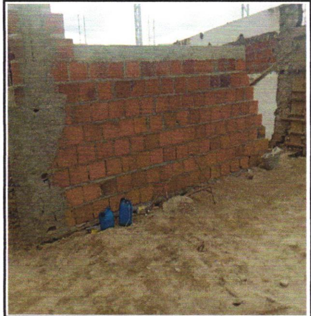
FOTO - 22 VERGA PRÉ-MOLDADA COM ATÉ 1,5 M DE VÃO, ESPESSURA DE *20* CM.AF_03/2024
